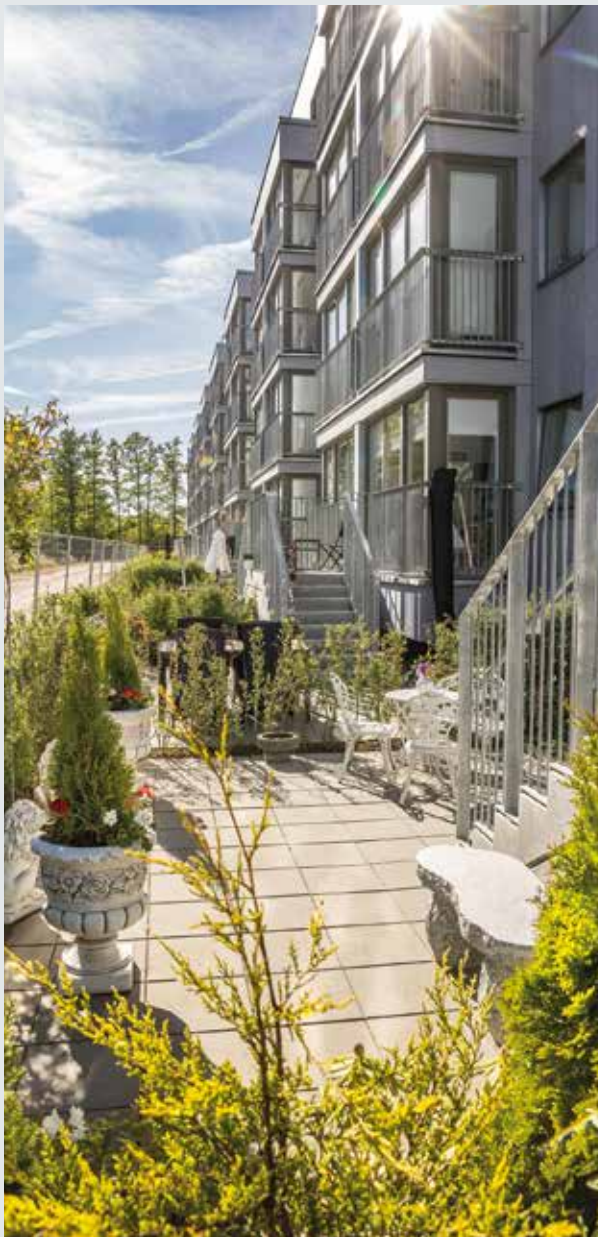
Det er både nybyggeri og renoveringer, der udsættes eller aflyses. Billedet viser et vellykket og færdiggjort eksempel på renovering. Det er fra KAB's byggeri Ellebo Blok 3 i Ballerup, der i fjor var nomineret til Renoverprisen.
